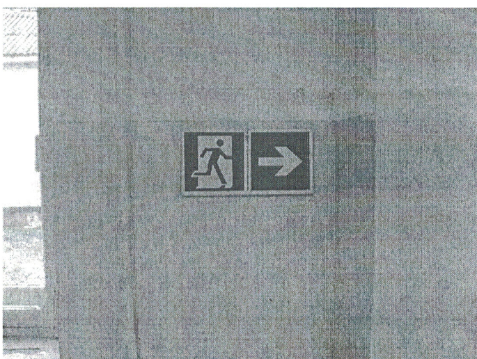
Фото 11. Путь эвакуации Правая часть рекреации (на Плане - №10)
